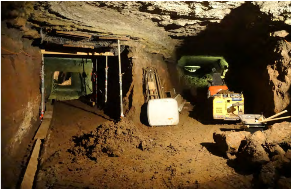
Die ersten Meter des Hauptstollens präsentieren sich leer geräumt. GHI
